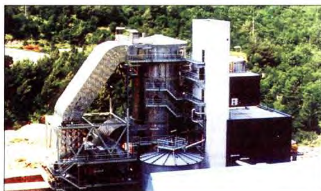
Slika 2. TE Plomin, postrojenje za odsumporavanje Photo 2 TE Plomin, desulphurization compound
