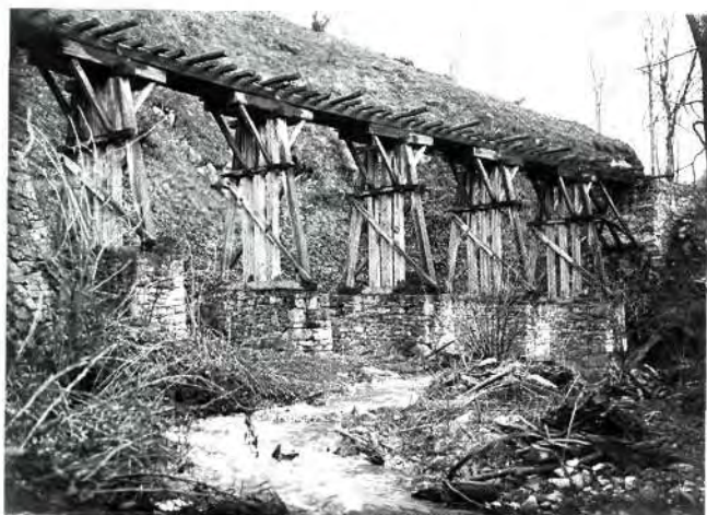
Slika 3. Konstrukcija visokih stupišta Figure 3 Construction of high piers
