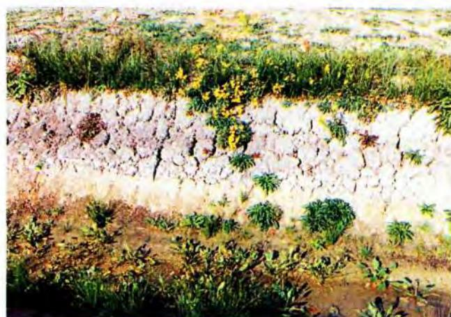
Slika. 10. Raspucani površinski glinasti horizont u odvodnom kanalu (Poljanski Lug)
