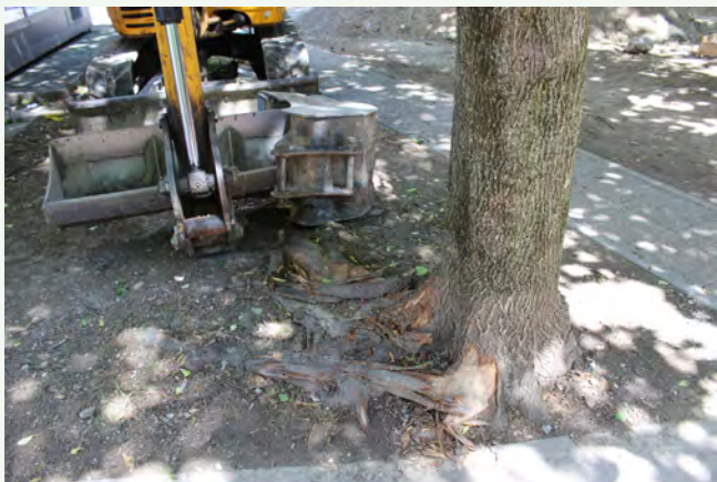
Slike 13 i 14. Nedozvoljeni rad građevinskog stroja u neposrednoj blizini stabla sa vidljivim oštećenjima debla, pridanka i korijena.
