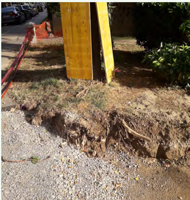
Slika 11. Skidanje gornjeg sloja tla, oštećenje korijena i navoženje kamenog materijala.
