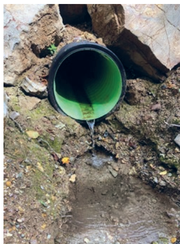
Slika 3. Dobro stanje cijevnog propusta Figure 3. Good condition of the Pipe culvert
