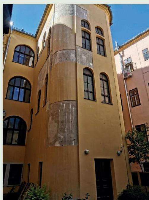
Sanirana vanjska stubišta (Glavno stubište) i novi fasadni dimnjaci
