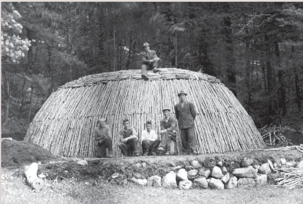
Poveća složena žežnica pred pokrivanje šćupom i palenjem u Zelinskom lugu 1960.g. Slijeva: Ivan Turk, Franjo Kvaternik, Tomo i Josip Pavlić te lugal Vlado Turk; na vrhu kope mladi lugal Vlado Janeš Tilin. Prinosnik: Franjo Franić Turk, Gerovo
