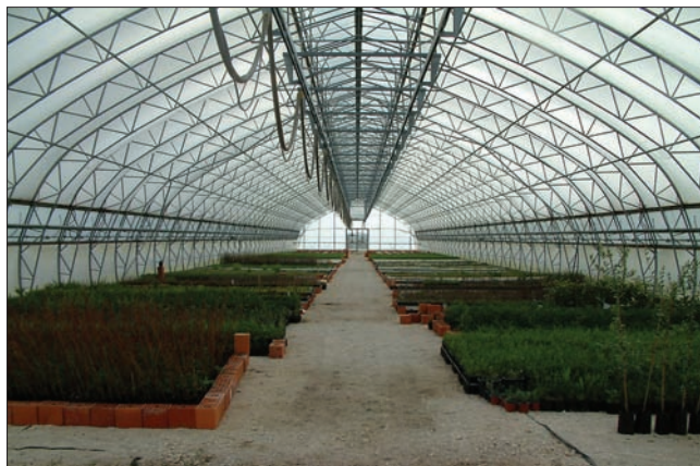
Suvremeni plastenik s automatiziranim sustavom zagrijavanja/hlađenja i prskanja
