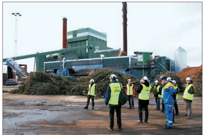
Slika 5. Skladište šumske sječke
