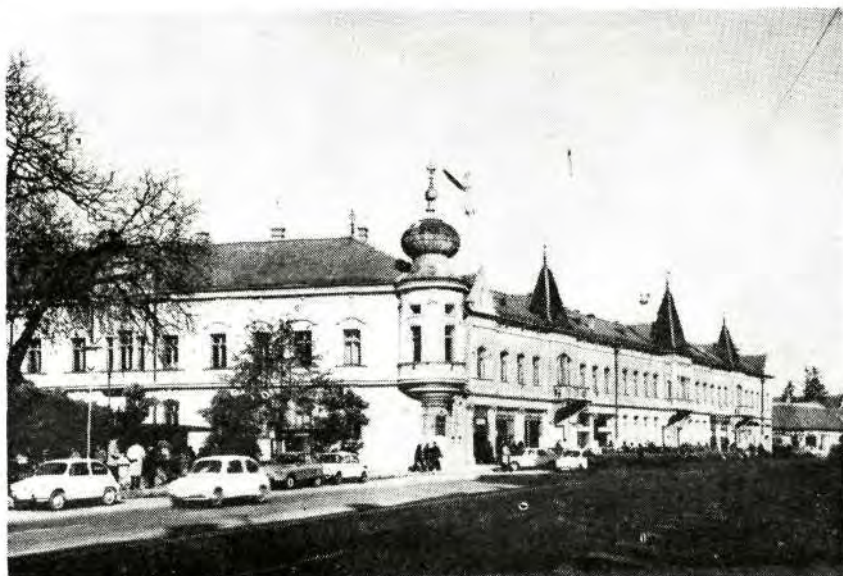
Sl. 1. Zgrada Gospodarskog ureda Brodske imovne općine u Vinkovcima.
