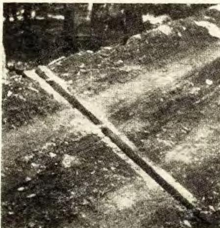
Sl. 1. Odvodni jarni preko puta izgrađeni od drvenih gredica
