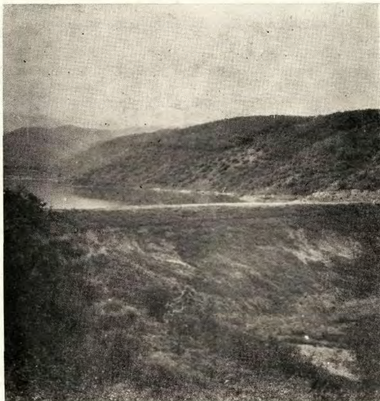
Mikro-akumulacija vode za poljoprivredu sa zemljanom branom G. S. SOFIJA
