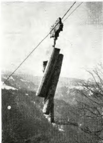
ŽIČNA DIZALICA KS-1, nosivosti 1200 kg, opremljena automatskim zaustavljačima
