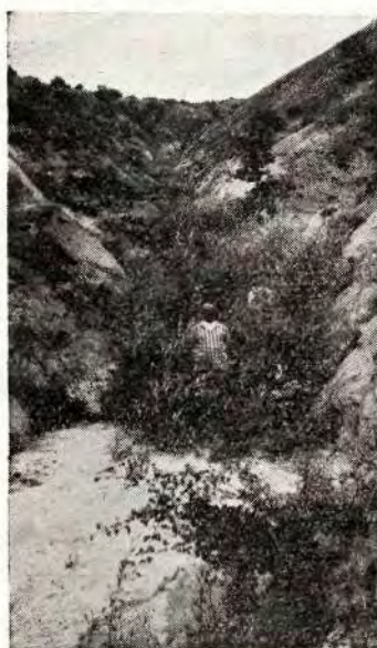
Sl. 8. Živi pleteri u sistemu fotografisani 3 meseca nakon izrade u bujici »Bela Dolina« u srezu preševskom.
