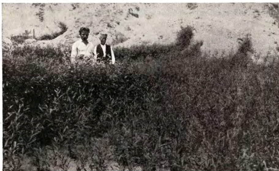
Sl. 4. Poslednja pregrada od pletera i palisada od vrbovog kolja u bujici »Beloj Dolini« u srezu preševskom. Fotografisano je nakon 3 meseca od izrade.
