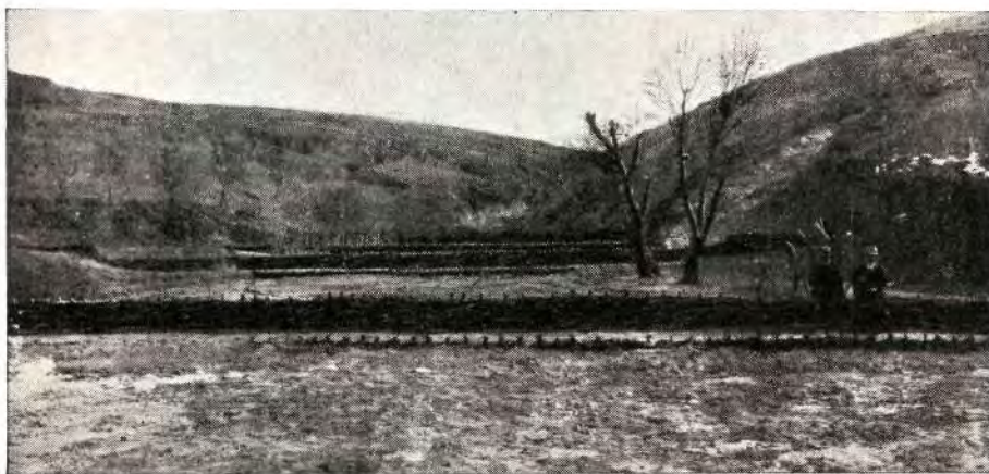
Sl. 6. Sistem živih objekata na gornjem delu čuna nanosa bujice »Vrbanov Dô« u srezu preševskom. Fotografisano je nakon 5 dana po izradi.
