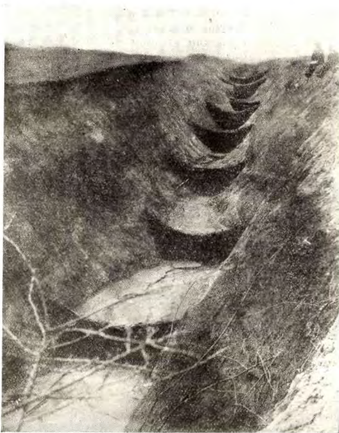
Sl. 7. Klasičan primer upotrebe živih pletera u sistemu. Fotografisano je 3 dana nakon izrade, a posle prolaza voda, koje su već pokrile podslaplja materijalom.
