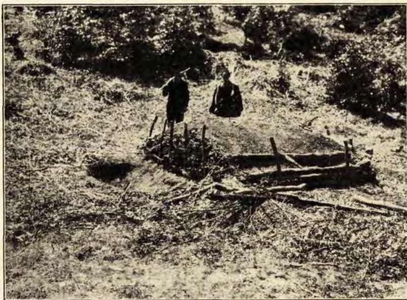
Сл. 4. Изглед угљенарнице, код које је угљенисање већ довршено, па се хлади.
