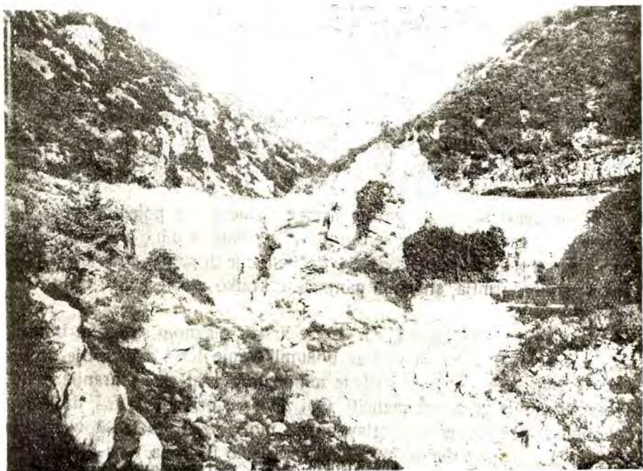
Sl. 5. Uređivanje bujica. Primarna pregrada izvedena u polukrugu. Štednja na materijalu — iskorišćena prirodna pećina. Senjska Draga.
