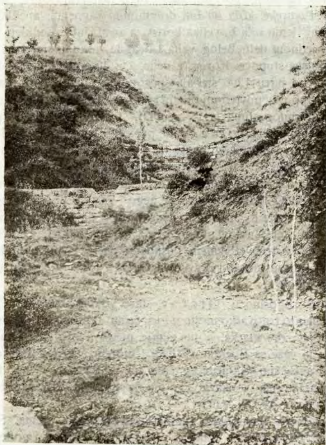
Sl. 3. Bujičarske radnje (sa pošumljavanjem zasutog korita) u Zrmanji.
