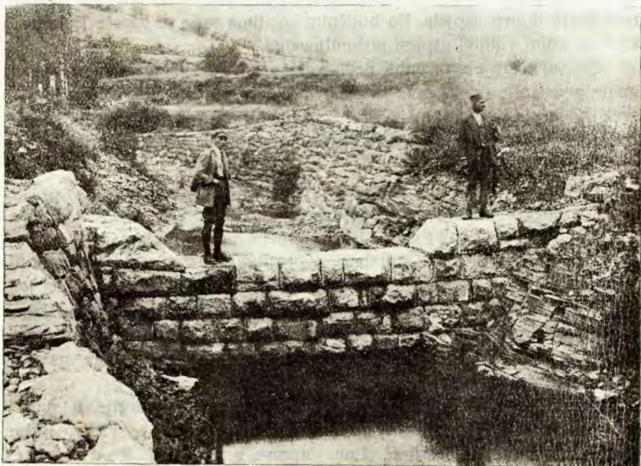
Sl. 2. Uredjivanje bujica. Novosagradjena sekundarna pregrada u bujici Gudura Zrmanja.
